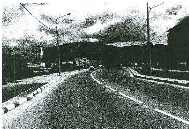
Реконструкция дорожного покрытия
